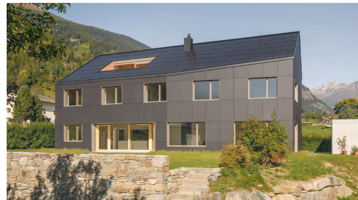
La maison à énergie positive d'hiver Sol'CH située à Poschiavo (GR) est un exemple parfait, et primé, d'installation photovoltaïque intégrée. L'ensemble de l'enveloppe du bâtiment, façade nord comprise, est composé de panneaux photovoltaïques.
