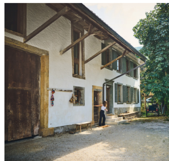
La façade sud de la maison paysanne d'Oltingen, qui présente un intérêt historique, a été simplement rafraîchie.
