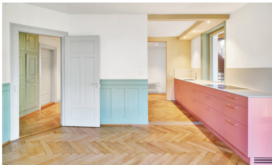
Les marches d'escalier ont été transformées en seuils de porte, le parquet à chevrons était caché sous une moquette.
