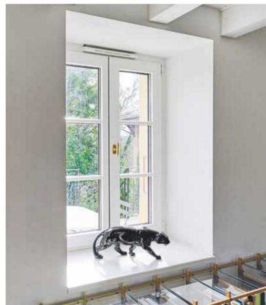
Incassato in modo elegante: isolamento supplementare di 30 cm e finestre a triplo vetro sormontate dalle bocche di aerazione.
