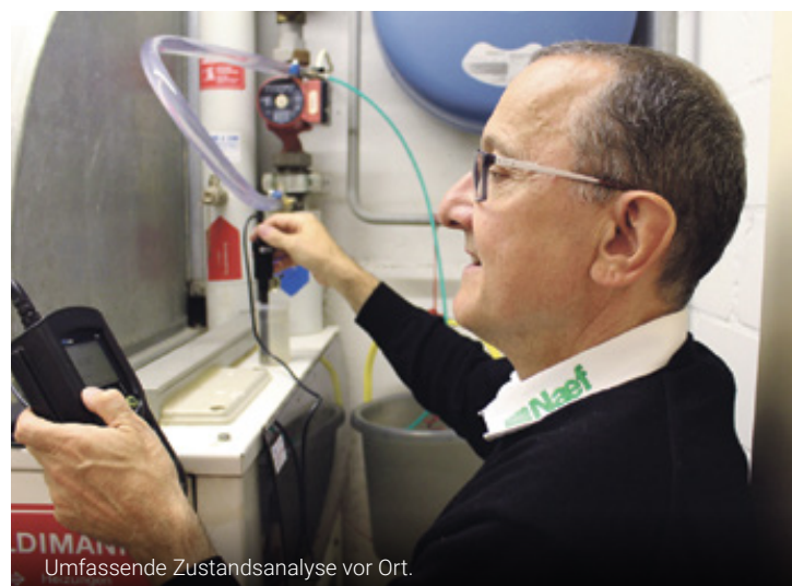
Umfassende Zustandsanalyse vor Ort.
