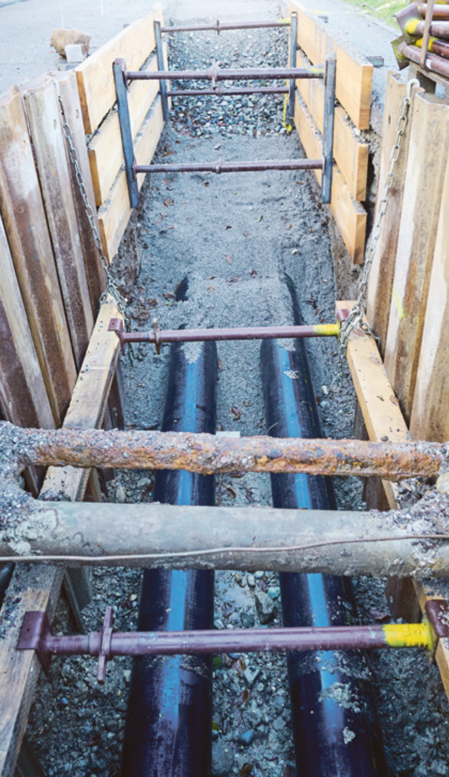
Die Fernwärmeleitungen in Fehraltorf verdichten sich. Im Herbst sollen die ersten Häuser versorgt werden.
