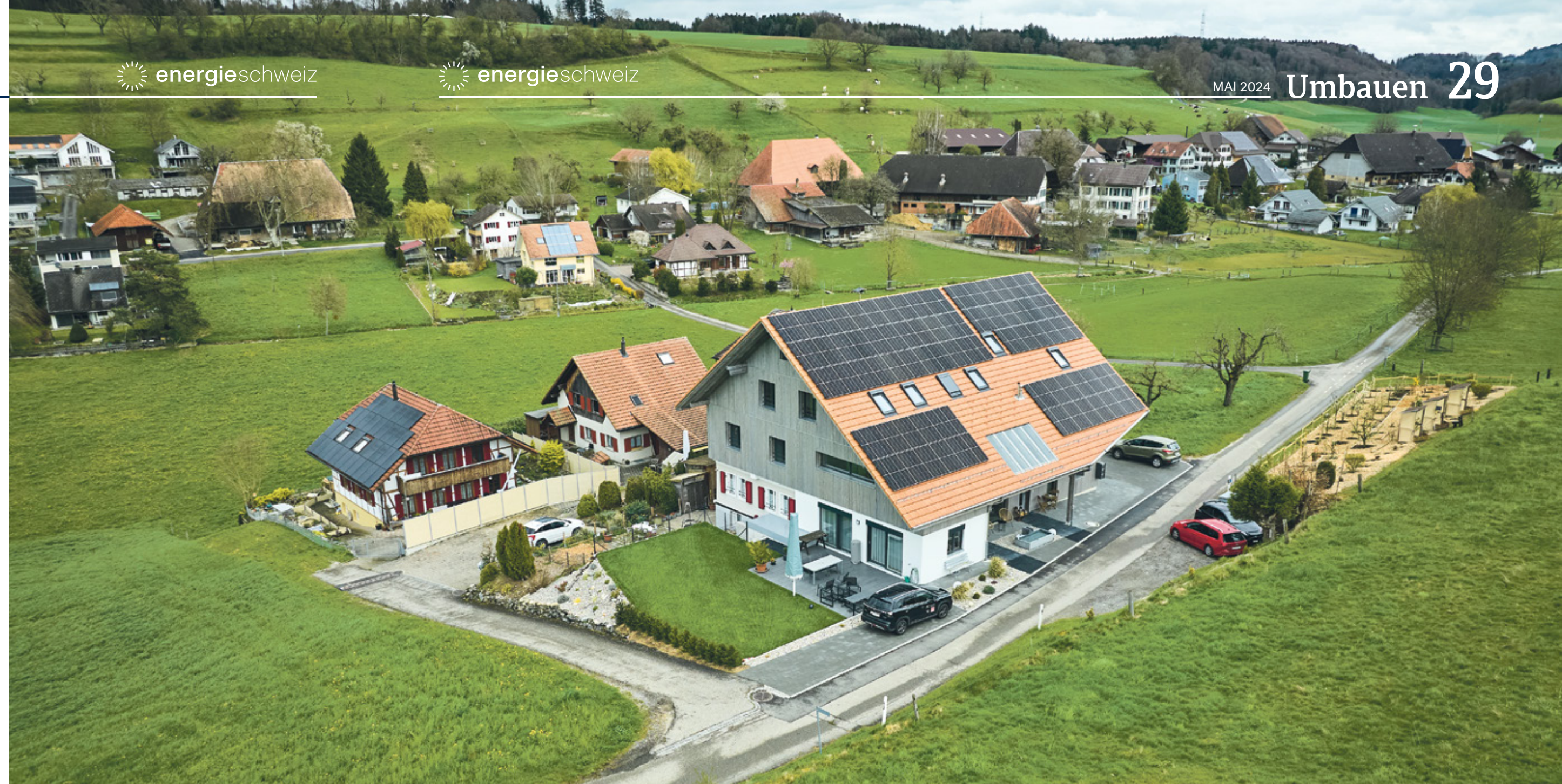
Die Südseite des Giebeldaches ist mit einer Photovoltaikanlage belegt: Ihr maximales Leistungsvermögen beträgt 30 Kilowatt.
