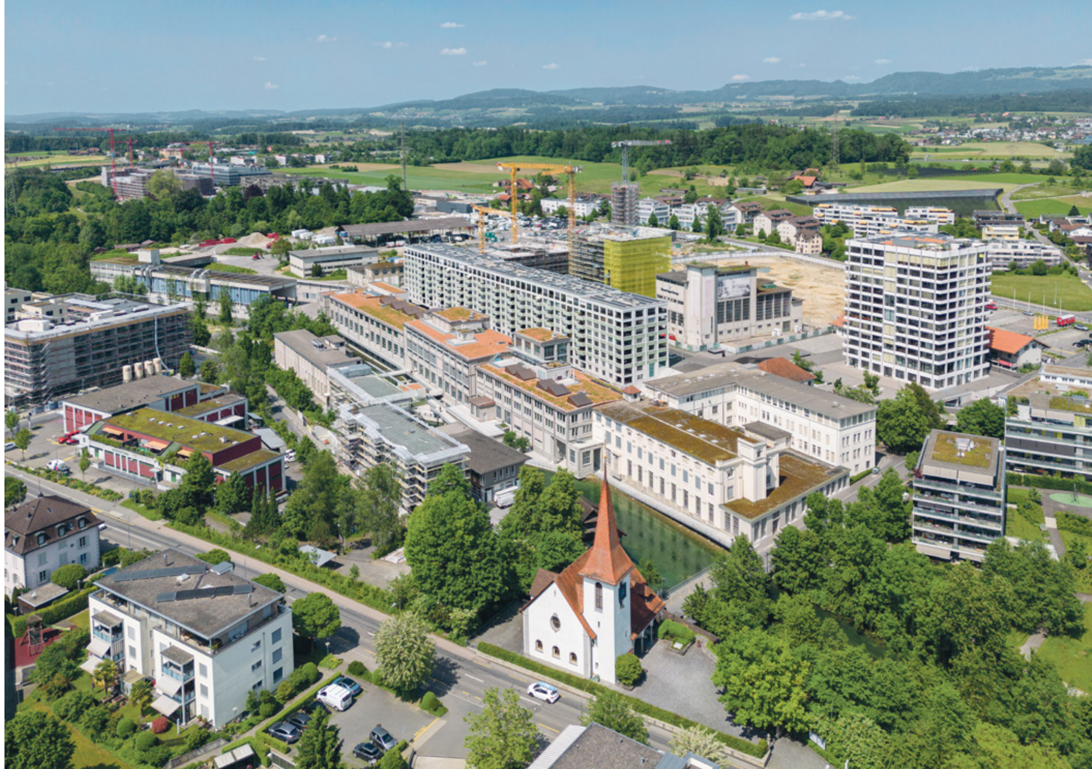
Das integrierte und CO 2 -freie Konzept des Papier-Areals in Cham ZG schöpft aus verschiedenen lokalen Energiequellen und entlastet das Verteilnetz.
