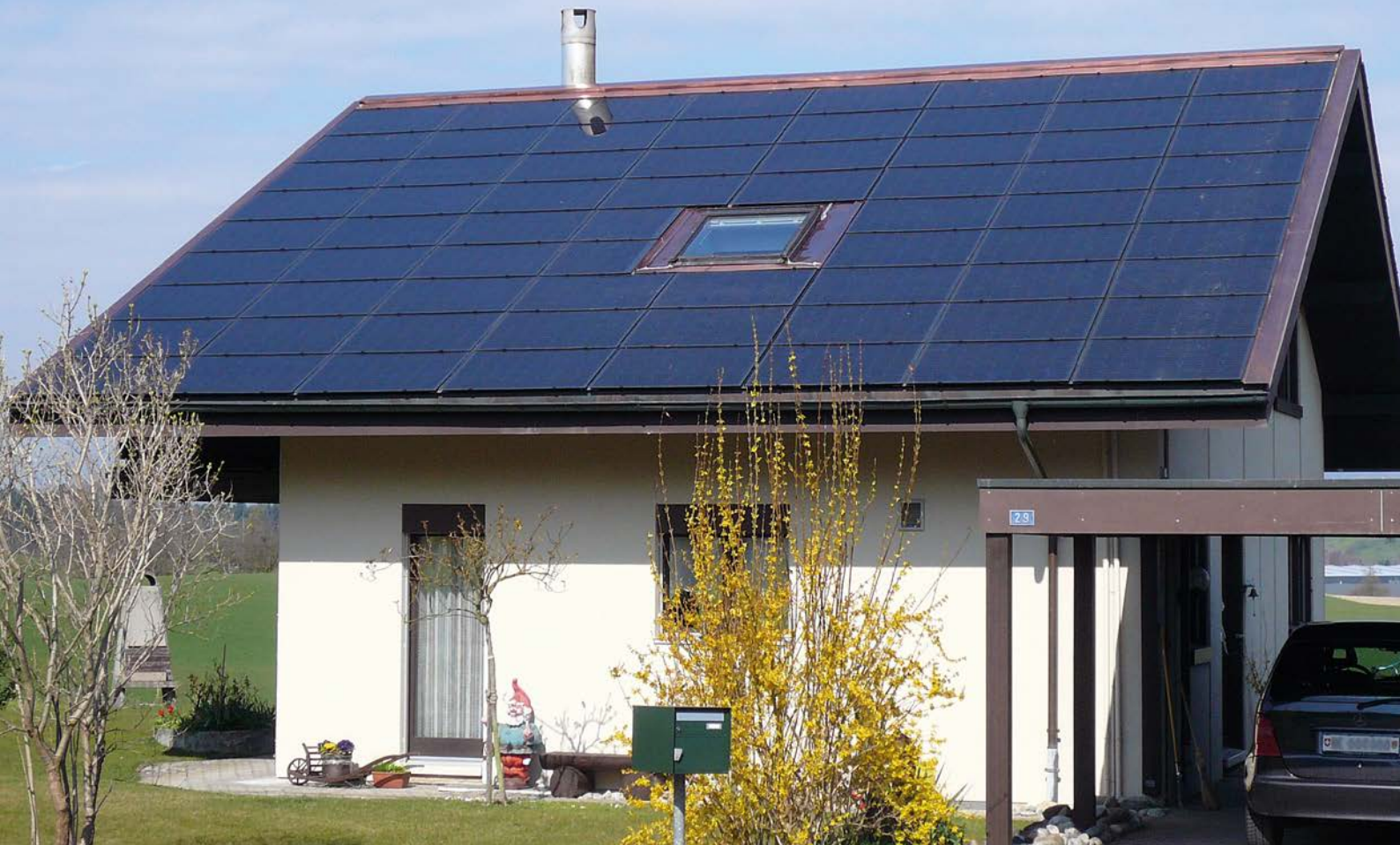
Installation PV intégrée sur le toit d'une maison individuelle
