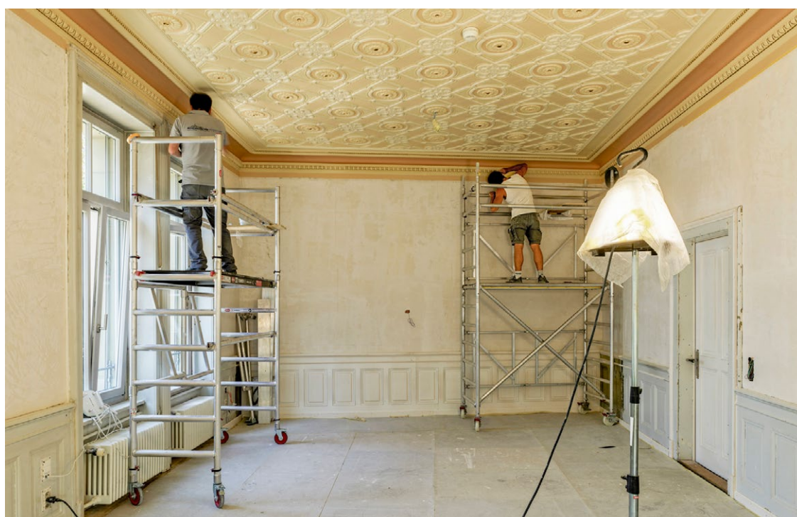
Lavori di ristrutturazione in Eigerplatz a Berna (foto: Alexander Gempeler)
