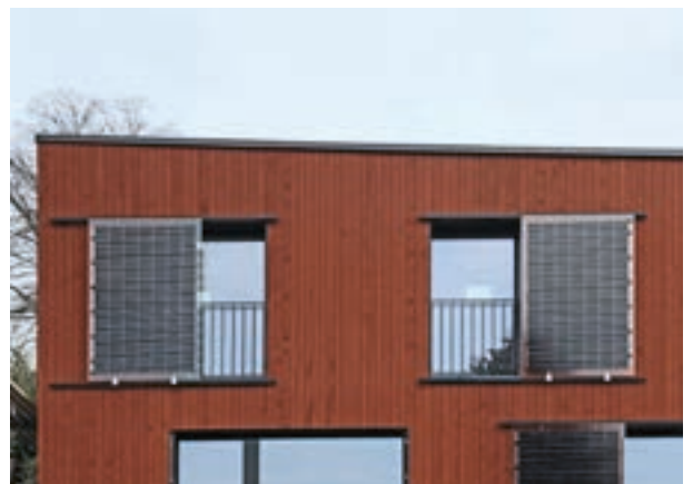
VOLETS COULISSANTS SOLAIRES POUR IMMEUBLE D'HABITATION, WIESENSTRASSE, KÜSNACHT Architecture : Vera Gloor, Zürich Partenaire spécialisé, photovoltaïque : Leutenegger Energie Control, Küsnacht
