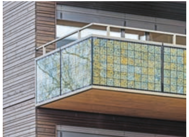
GARDE-CORPS DE BALCONS AVEC MODULES PV POLYCRISTALLINS POUR L'IMMEUBLE D'HABITATION DE LA ZWYSSIGSTRASSE, ZÜRICH Architecture : kämpfen für architektur AG, Zürich
