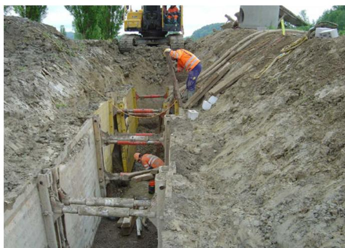
*Neue Hauptleitung zum Entwässerungspumpwerk in 4 m Tiefe*
