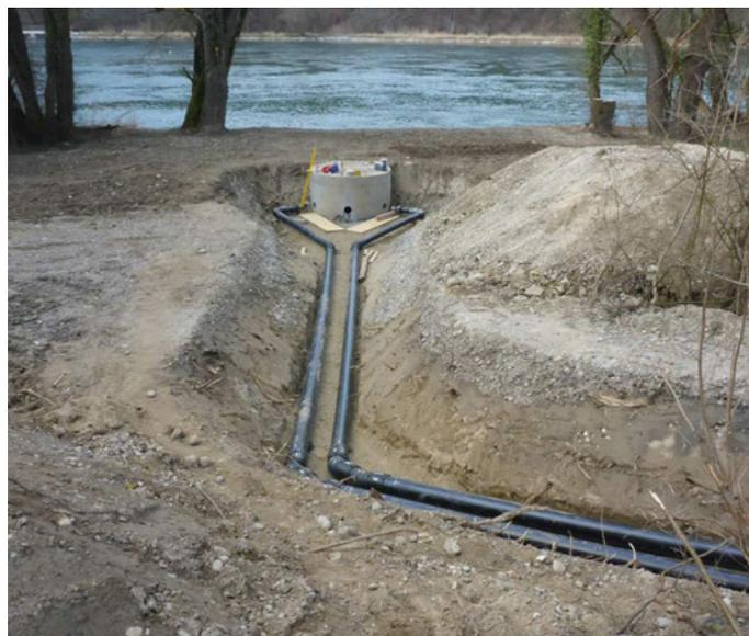
*Bewässerungspumpwerk, Pumpenschacht mit angeschlossenen Druckleitungen*
