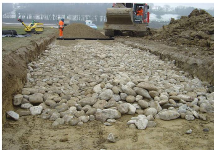
Strassenbau, Verstärkung des Oberbaus mit Bollensteinen und Geotextil
