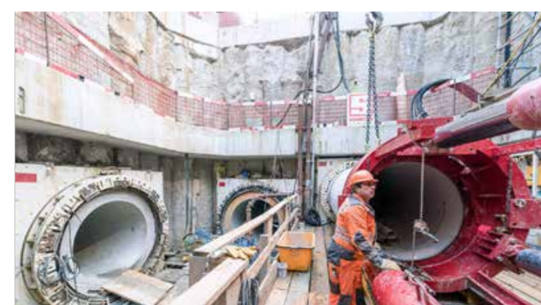
Sous-sol de la ville de Zoug: en 2017, début des travaux pour le réseau de chaleur et de froid Circulago; en 2020, mise en exploitation de la première centrale de quartier. Photo: Andreas Busslinger
