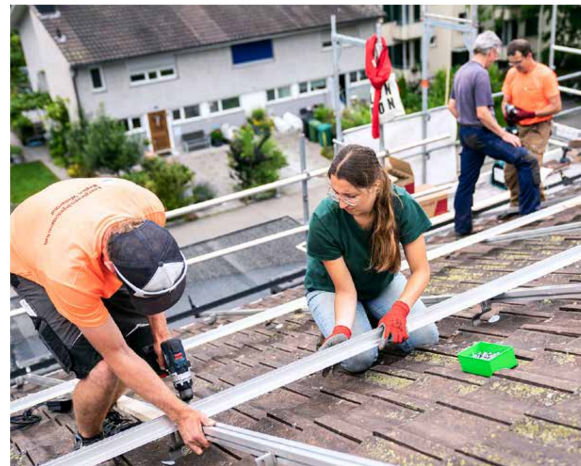
Reconnaisables à leur t-shirt orange, les chefs de chantier sont responsables de l'instruction, de la sécurité au travail et des étapes de travail plus complexes.
