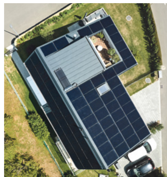
Il tetto è provvisto di celle fotovoltaiche e di un impianto solare termico.
