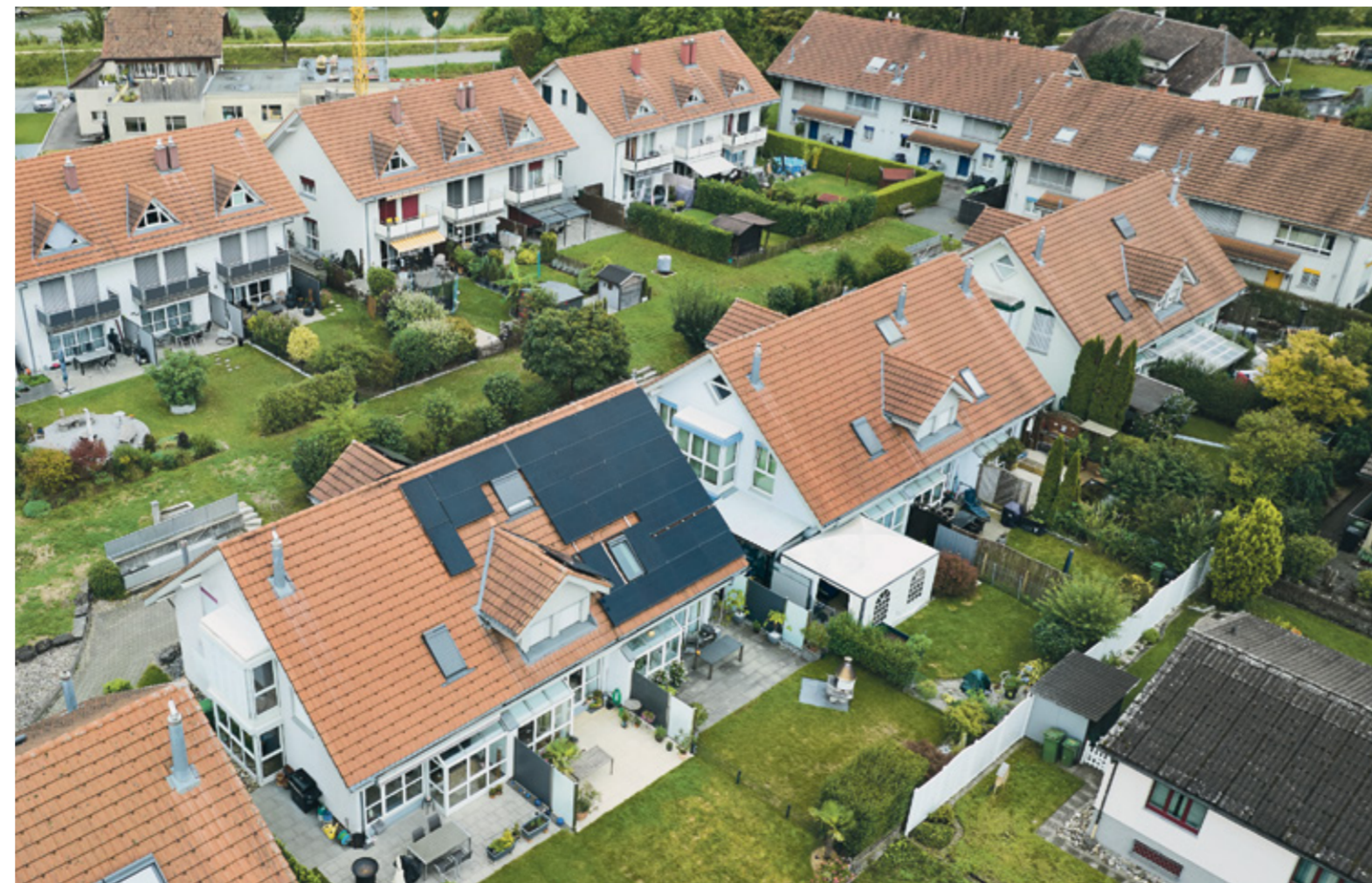
La casa di Lohberger si riconosce immediatamente nel complesso di case a schiera riscaldate a gas. Il suo vicino gli ha affittato la superficie del tetto per l'impianto FV.
