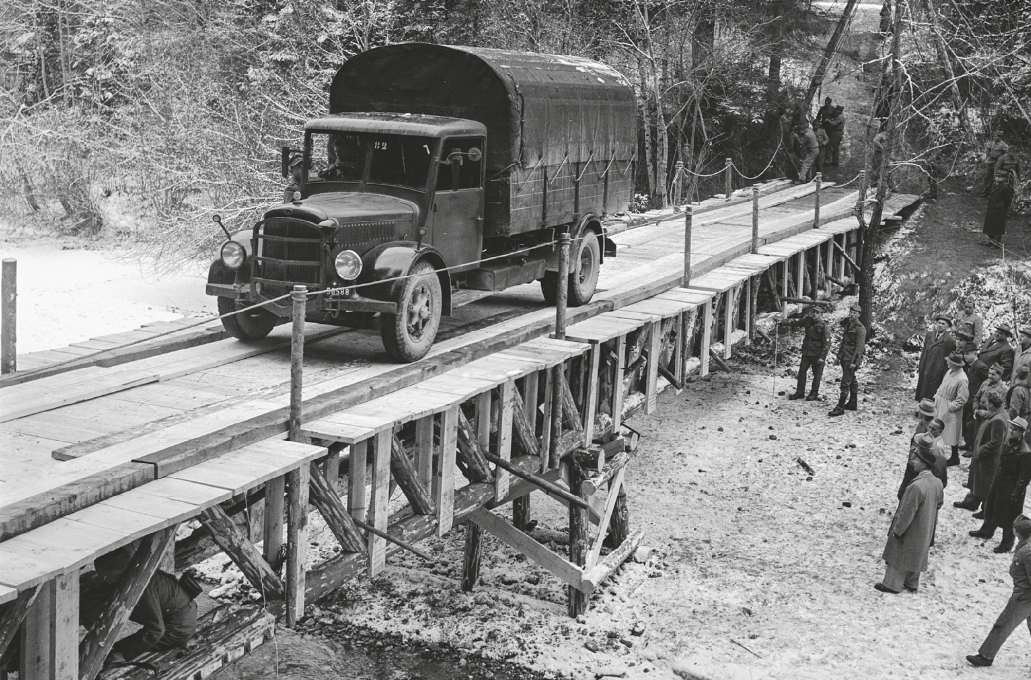
Übersetzen auf einer Fachwerkbrücke bei Heimberg am 12. Mai 1953.
