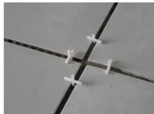
En croix. Pour un écartement constant et un alignement parfait des carreaux avec des joints réguliers et homogènes. En PS Choc rigide. Couleur bleue. *(jetable, invisible sous le joint).*
