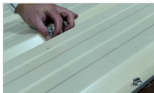
Pose de vis auto-foreuse pour bardage Self-drilling screws for siding
