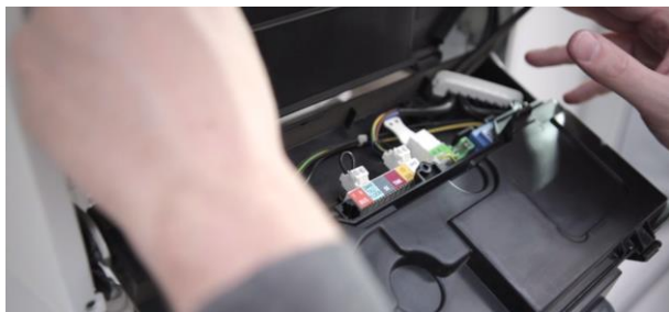
12. Ouvrez la chaudière et l'accès aux connecteurs
