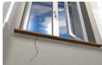
Fermeture de fissures de mur à l'intérieur
