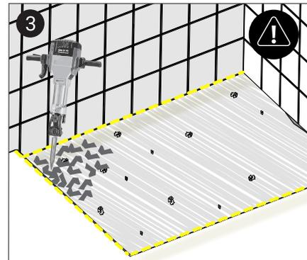
3 Retirez soigneusement le revêtement de sol en fonction de la hauteur finie du receveur et du revêtement de sol final.
