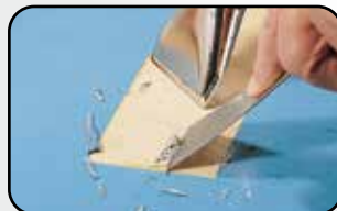
Décapage de peinture Paint stripping
