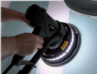
Éclairage LED : idéal pour voir les défauts de planéité LED lighting: usefull to see plasterboard coating defects
