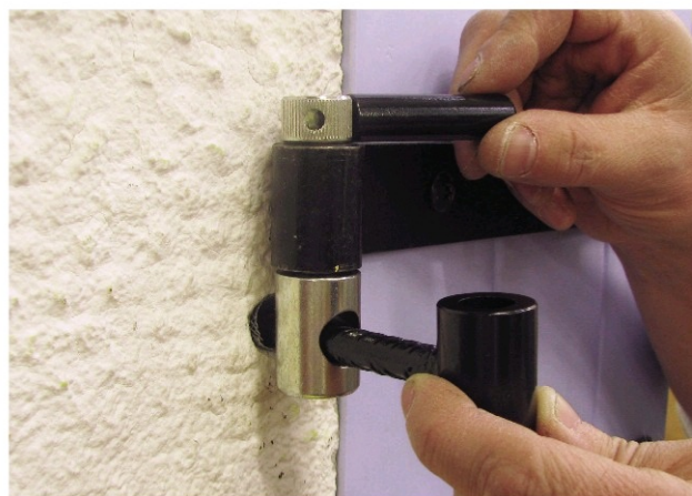
Le bloquer à l'aide de la clavette et de la queue du gond.
