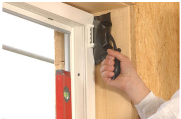
Pose de menuiseries
