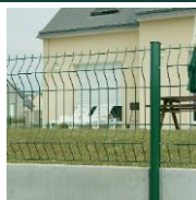
Pose avec plaque de soubassement
