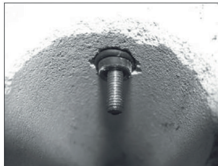
Mise en oeuvre dans maçonnerie creuse
