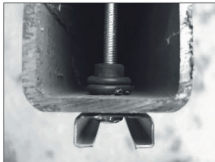
Mise en oeuvre dans tubes métalliques
