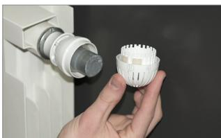
**3b)** Pour verrouiller la plage de réglage, la position du limiteur à droite du numéro correspondant à l'ouverture maximale souhaitée et le limiteur à gauche du nombre correspondant à l'ouverture minimale souhaitée. Cela empêche la tête d'être ouverte ou fermée.
