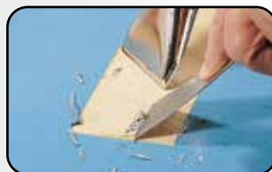
Décapage de peinture Paint stripping
