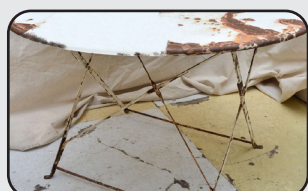
Décaper les surfaces planes Strip flat surfaces
