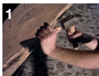
Bûchage des parties atteintes et balayage des poussières
