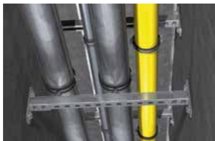
Fixation de tuyaux d'évacuation
