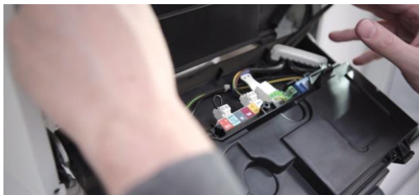
13. Ouvrez la chaudière et l'accès aux connecteurs
