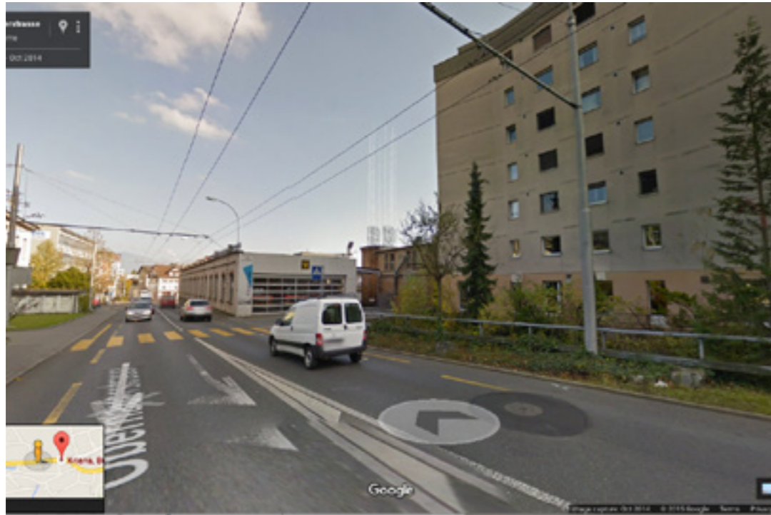
Ansicht von Obernauerstrasse
