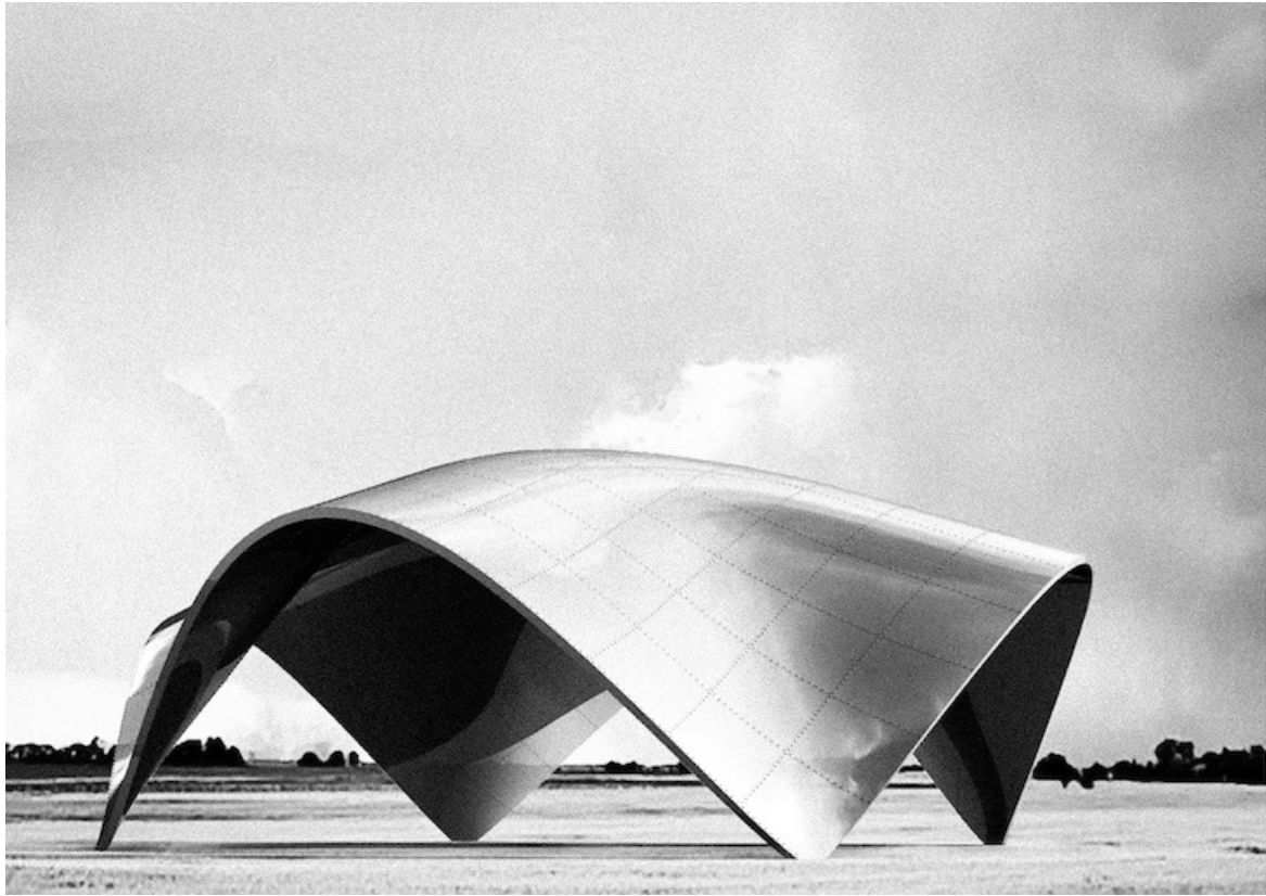
Freiformstrukturen aus flächigen Metallpaneelen
