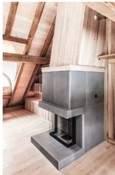
In der Küche und im Kaminzimmer steht jeweils ein Cheminée mit Sandsteinverkleidung und Glasscheibenzug.
