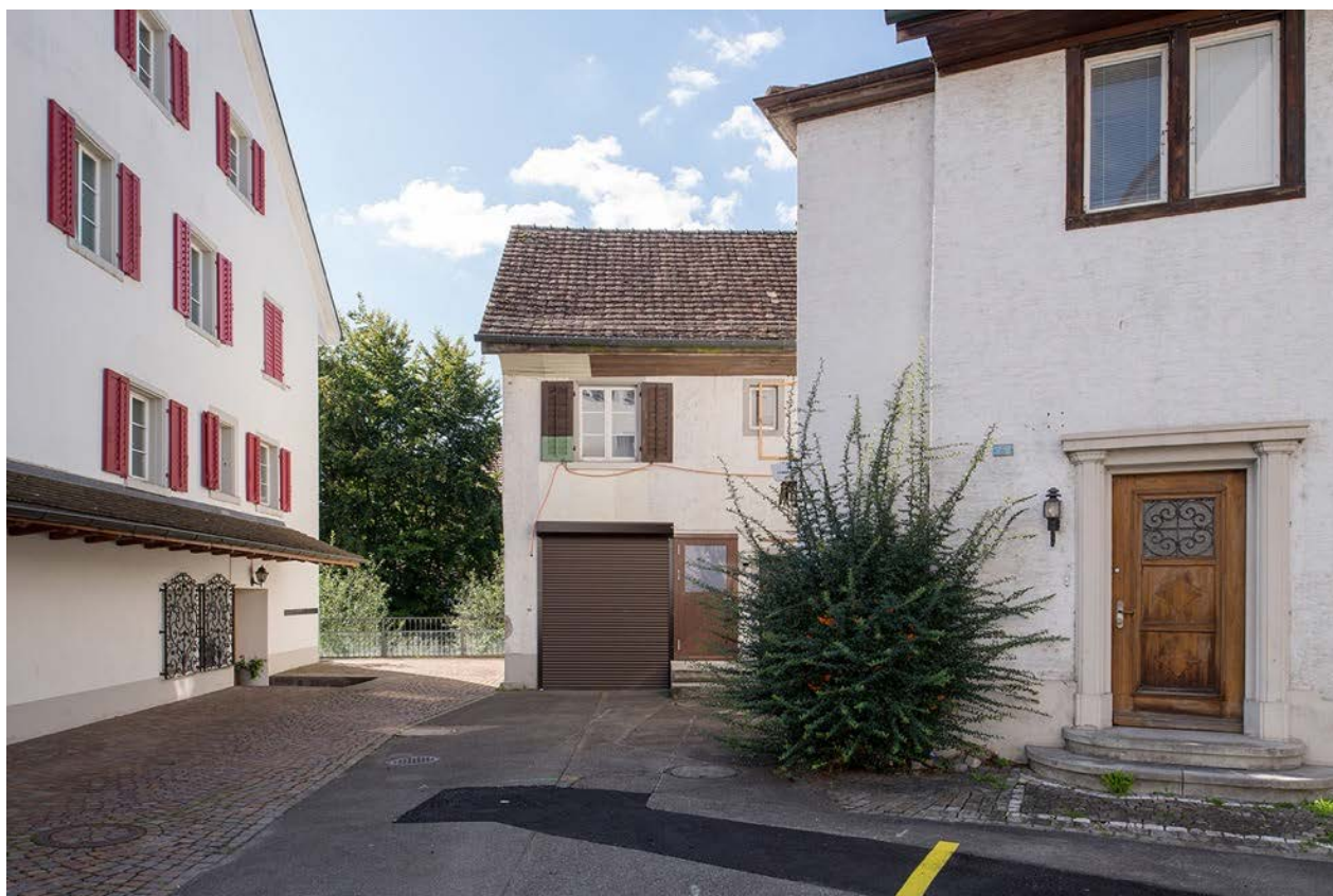
Abbildung 20 – Das Gebäude Kronenplatz 10 (Bildmitte) ist von den Nachbargebäuden etwas zurückversetzt
