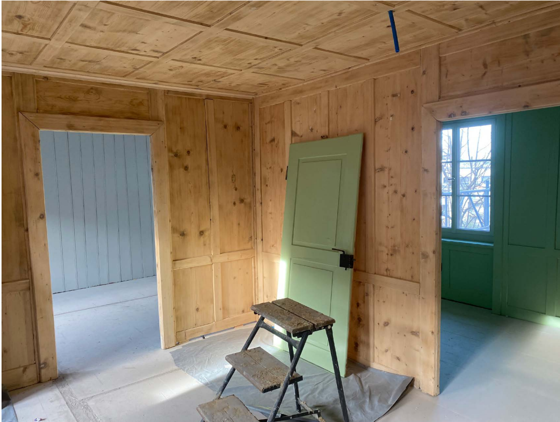
Abb. 11: Wohnung 2. OG neu gestrichene und abgelaugte Wandoberflächen (Foto: Curschellas & Gasser Architekten)
