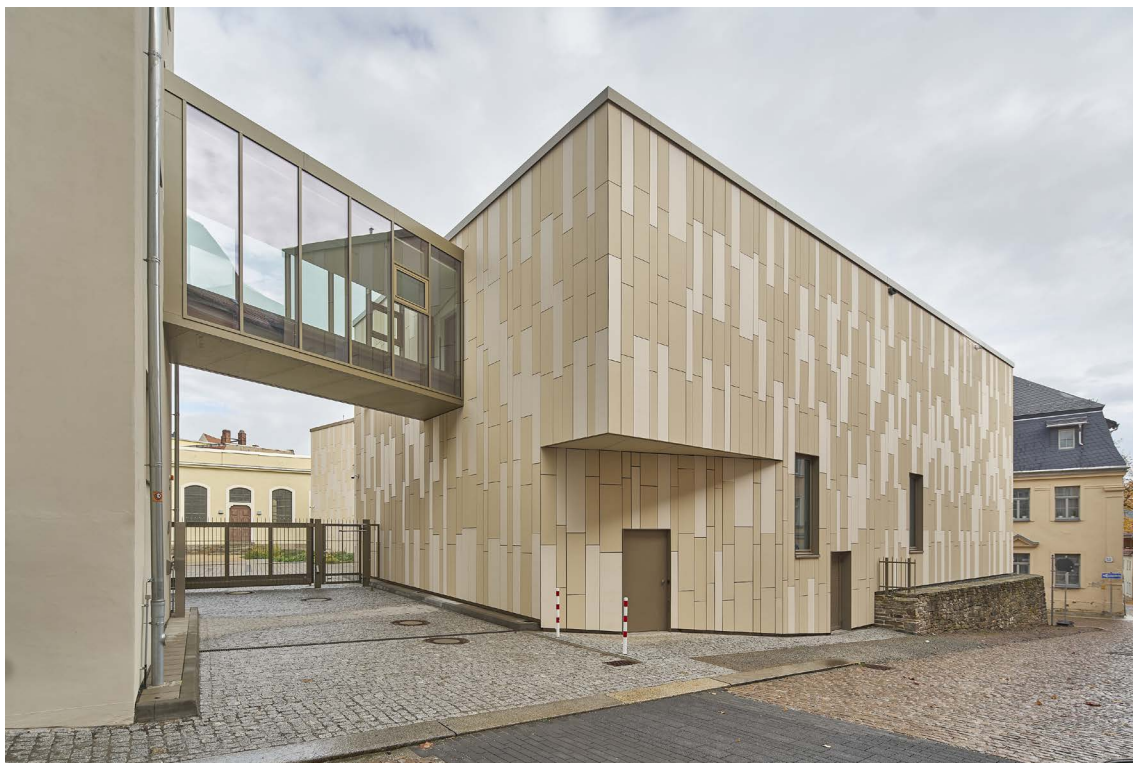
Abb. 11: Der Magazin-Neubau mit Verbindungsbrücke (Foto: Stephan Falk)
