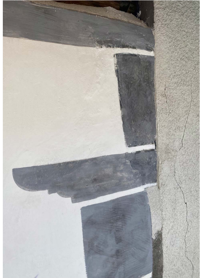
Abb. 7: Fassadenmalerei (Foto: Curschellas & Gasser Architekten)
