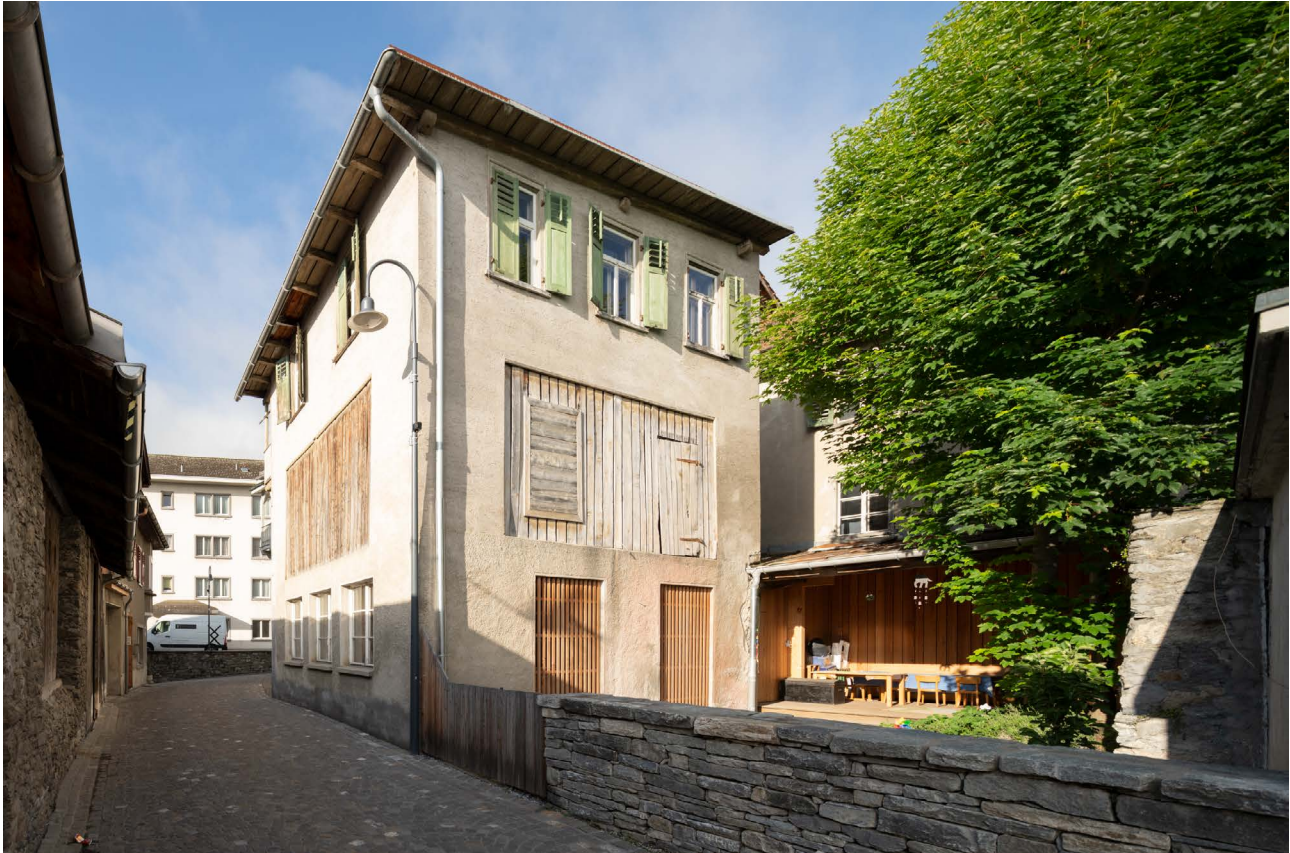
Abb. 4: Rathausgasse Stallscheune mit Erweiterung (Foto: Jaromir Kreiliger)
