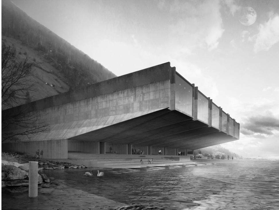
Der freistehende Baukörper wird durch eine gerichtete Schottenstruktur gegliedert, die zugleich die Haupttragstruktur bildet. Durch das Aneinanderreihen mehrerer Wandscheiben mit einem
