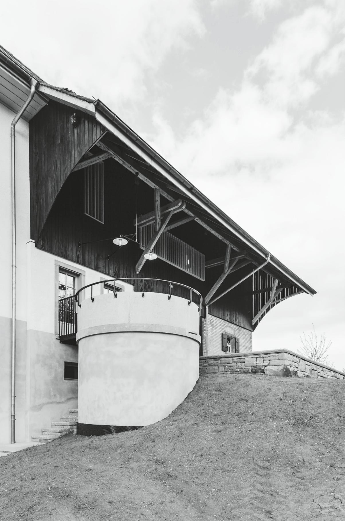
Die Wohnhaus- und Stallwände wurden beim Bau des Bauernhauses im Jahr 1924, wie damals in dieser Region üblich, in Massivbauweise ausgeführt: im Kellergeschoss aus Beton und in den darüber liegenden Geschossen aus Backstein. Erstaunlich ist, dass schon zu dieser Zeit im Wohnbereich und im Stall, wo bessere Dämmeigenschaften erwünscht waren, die Backsteinaussenwände als Zweischalenmauerwerk mit zirka fünf Zentimeter Luft zwischen innerer und äusserer Schale ausgeführt wurden.
