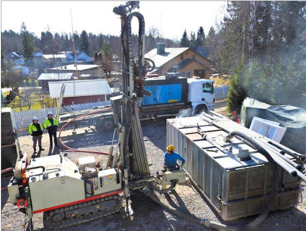
Kuva 1. Energiakaivon porausta. Etualalla on porakone ja sen vieressä poraussoijan umpinainen keräyslava. Koneen takana, kuorma-auton lavalla on kompressorit. Kuva: Timo Rajala, TimFoto ystävällisellä luvalla.
