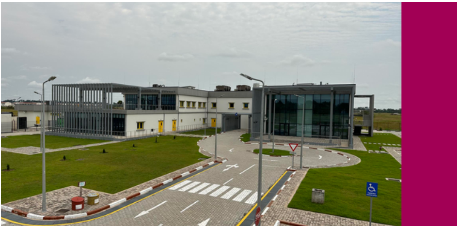
Figure 1: View of the main CEO building. (Photo Credit: Centre d'Excellence d'Oyo pour les Energies Renouvelables et l'Efficacité Énergétique (CEO))
