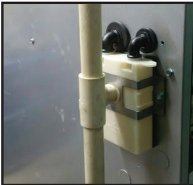
4. Pour une sécurité additionnelle, si désiré, il est recommandé de fixer une bande métallique autour du purgeur. Utilisez les vis du purgeur de condensat pour fixer la bande métallique.
