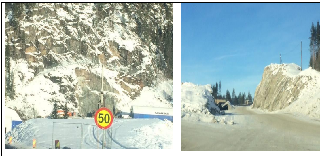
E 16 med innslag av tunnelen i Bagn og gjennomslag ved Klogsbøle.
