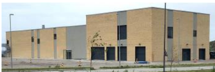
22. juni ble det nye renseanlegget på Hagelin offisielt åpnet.
