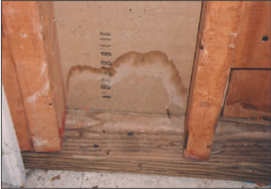
Mancha de agua en la pared de un sótano – ubicar y corregir prontamente la fuente del agua.
