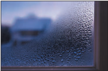
Condensación en el interior del vidrio de la ventana.
