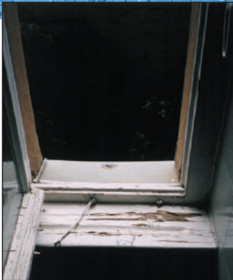
Ventana con fugas - el moho está empezando a crecer en el marco de madera y en el apoyo de la ventana.
