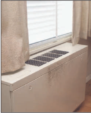
Moho creciendo sobre la superficie de un ventilador.
