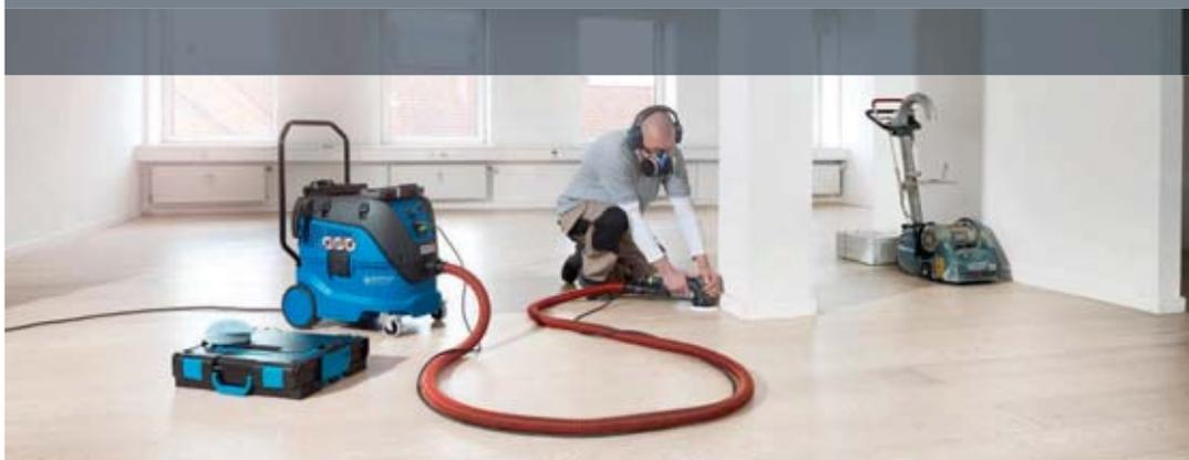
Besonders für das Absaugen gefährlicher Stäube ist die Wahl des richtigen Saugers entscheidend, schließlich hängen betriebliche Gesundheit und Sicherheit von der Zuverlässigkeit und der Leistung des Geräts ab. Die ATTIX 33 und 44 Sicherheits- und Asbestsauger sind ideal geeignet, um gesundheitsgefährliche Stäube der Klassen M, L und H aufzunehmen.
