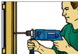
**7** Bohren Sie die Dübellöcher. Die Fuge zwischen dem Elementrahmen und Mauerwerk im Bereich der Befestigungspunkte mit Klötzchen hinterfüllen.
