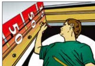
**6** Markieren Sie die Punkte für Dübellöcher im Mindestabstand von 15 cm aus der Ecke heraus und maximal 50 cm zwischen den einzelnen Bohrungen.
