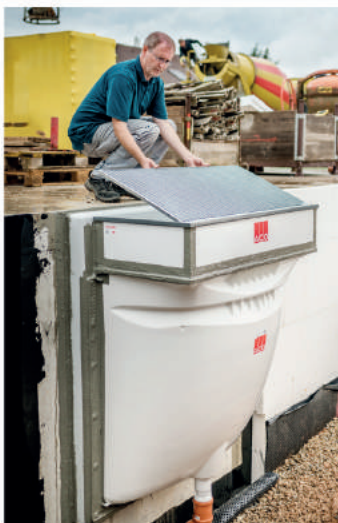
Druckwasserdichte Montage des ACO Lichtschachts mit Aufstockelement auf dem ACO Therm® Block
