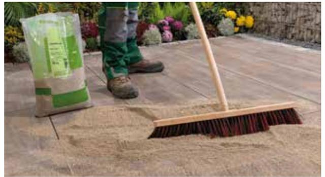
Nachdem die Fläche vollständig verlegt wurde, empfehlen wir Ihnen, die Fugen mit einem Fugenbrechsand (z. B. casafino Fugenbrechsand 0 – 2 mm) einzukehren. Damit verhindern Sie ein Verschieben der Platten und erhalten ein gleichmäßiges Fugenbild.
