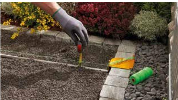
Legen Sie die Abziehröhre in die vorbereitete Bettung. Richten Sie die Abziehröhre mit Hilfe einer Schnur (z. B. Probst Schnur-boy-Set) in der Bettung auf die richtige Höhe ein. Die benötigte Höhe entspricht der Stärke des zu verlegenden Materials.
