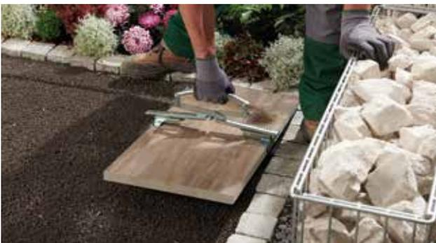
Beginnen Sie jetzt mit der Verlegung der Terrassenplatten mithilfe eines Plattenhebers. Starten Sie mit der Verlegung im Randbereich.
