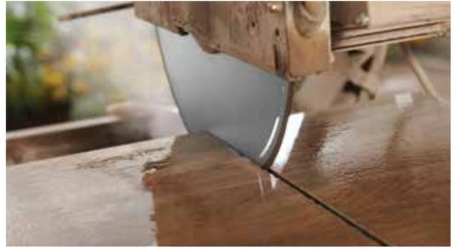
Für einen sauberen Randabschluss die Platten im Randbereich mit einer Nassschneidemaschine (Steintrennsäge) auf die benötigte Länge zuschneiden. Hierfür messen Sie den Abstand zwischen Randbereich und bereits verlegter Terrasseplatte. Wir empfehlen Ihnen, keramische Terrassenplatten mit einer Tischsäge mit speziellem Diamant-Sägeblatt im Nassschnitt zu schneiden.
