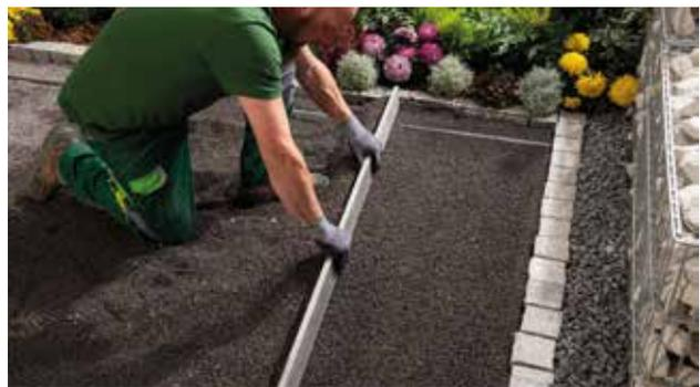
Ziehen Sie nun mit Hilfe einer Abziehlatte das Bettungsmaterial auf der richtigen Höhe entlang der Rohre ab, um eine ebene Oberfläche zu erhalten.
