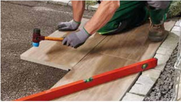
Anschließend klopfen Sie mit Hilfe eines Gummihammers (z. B. Simplex) die verlegten Platten in die Bettung. Damit verhindern Sie eine unregelmäßige Setzung der verlegten Platten.
