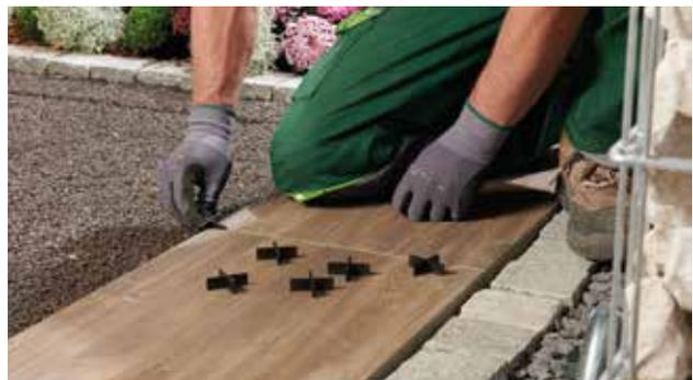
Um ein gleichmäßiges Fugenbild bzw. eine gleichmäßige Fugenbreite von 3 oder 5 mm zu erhalten, ist es zwingend notwendig, mit casafino Fugenkreuzen zu arbeiten. Verwenden Sie dabei je nach Verlegeart die benötigte Menge an Fugenkreuzen.
