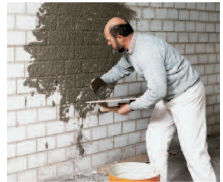
Ein mit PCI Emulsion hergestellter Spritzbewurf verbessert die Haftung von Putz.
