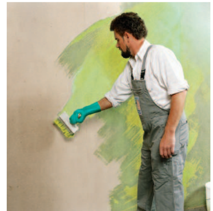
PCI Wadian als Wasserdampf bremsende Grundierung auf Holzspanplatten vor der Fliesenverlegung.
