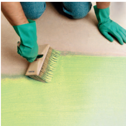
1. PCI Wadian im Kreuzgang oberflächendicht auf den Untergrund auftragen.
