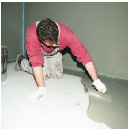
4. ... oder der zementären Sicherheits-Dichtschlämme PCI Seccoral
