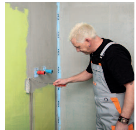
3. Nach Trocknung der PCI Wadian-Spezialgrundierung können Flächen mit der wasserdichten, flexiblen Schutzschicht PCI Lastogum ...
