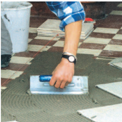
Nach ca. 30 bis 45 Minuten können nachfolgende Oberbeläge aufgebracht werden.
