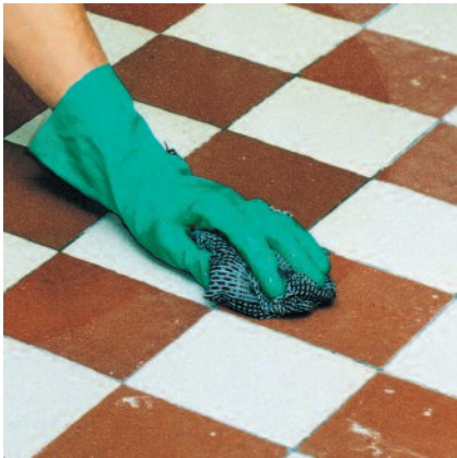
Untergrund mit geeignetem Reiniger (z. B. PCI Grundreiniger Intensiv)) von haftungsmindernden Rückständen säubern.
