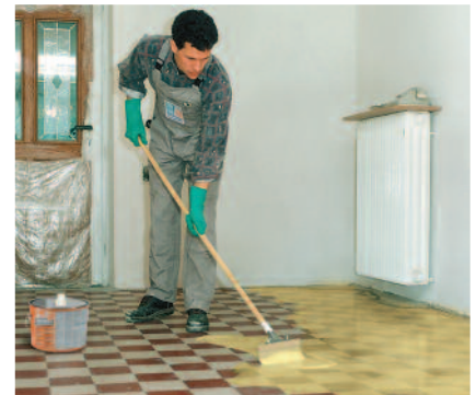
PCI Gisogrund 303 ist die sichere Haftgrundierung zum Verlegen von Belägen auf keramischen Fliesen und Platten.
