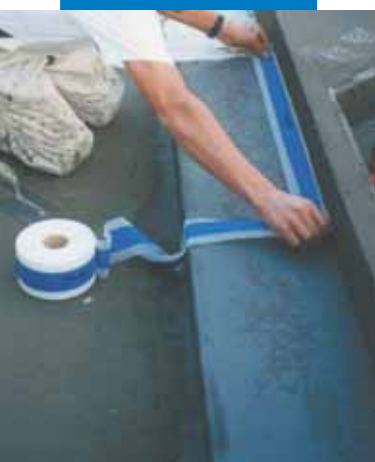
Einarbeiten von Mapeband im Anschlussbereich zur Badewanne
