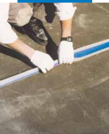
Schlaufenförmiges Einarbeiten von Mapeband
