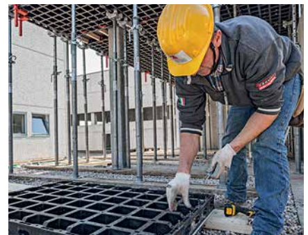
4. Festschrauben der neuen Schalhaut
