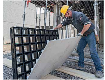
2. Entfernen der beschädigten Schalhaut
