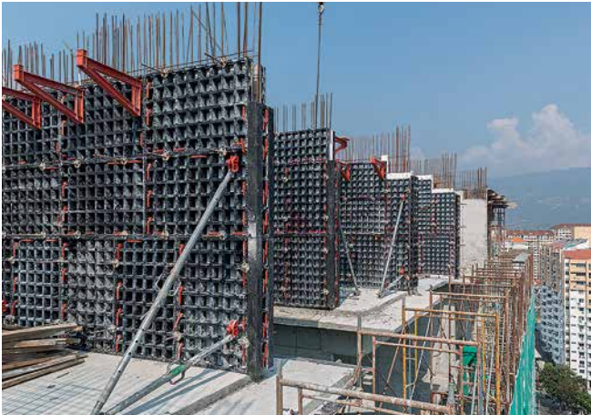
Erfolgreicher Ersteinsatz der leichten Systemschalung für die Herstellung von Wandscheiben
