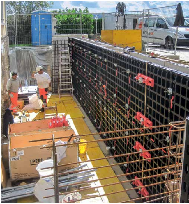
Umbau und Anbau ohne Kraneinsatz – bestens gelöst mit DUO
