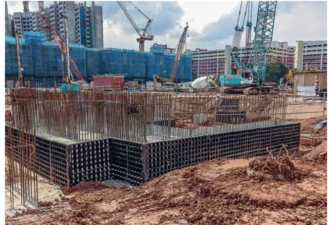
Aufwand für Reinigung und Nacharbeiten reduziert
