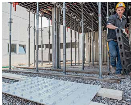
3. Bereitlegen der neuen Schalhaut
