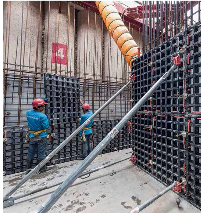
Geringes Gewicht, kleinformatige Schalungselemente – diese Vorteile spielt DUO bei diesen Tiefgeschosswänden voll aus
