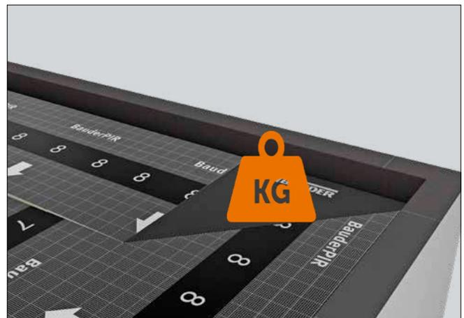
Im Gegensatz zur Vorgehensweise bei den Standardplatten sind die Füllstücke sofort stark anzudrücken bzw. ggfs. zu beschweren. Dies wirkt dem Aufgehen des Schaumes entgegen, so dass die Füllstücke sich optimal in die Kontur einpassen.
